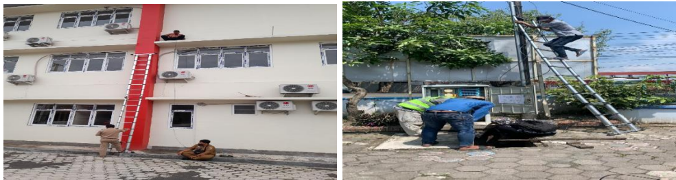
Kegiatan Uji Materi dan Tinjauan Lokasi Pengajuan Pembangunan Menara
